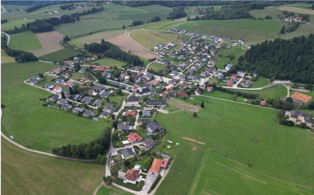
Abbildung 36: Meiselding mit Blick Richtung Westen 50
