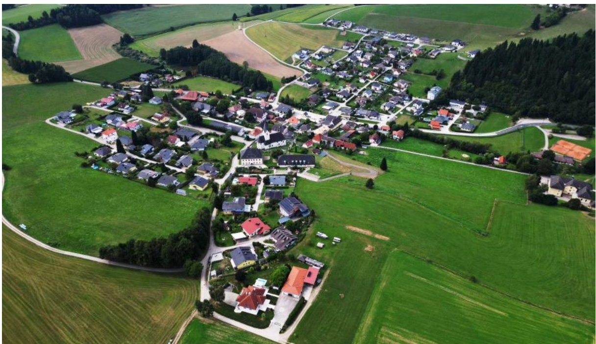
Abbildung 1: Luftaufnahme der Ortschaft Meiselding 1
